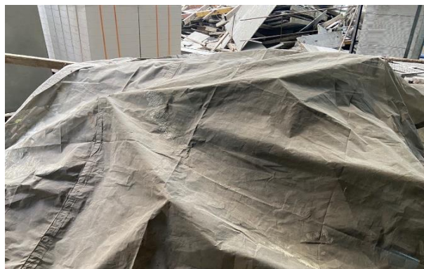
ภาพที่ ก-29 การปิดผ้าใบคลุมกองดินชั่วคราวและร่องระบายน้ำชะล้างกองดิน
