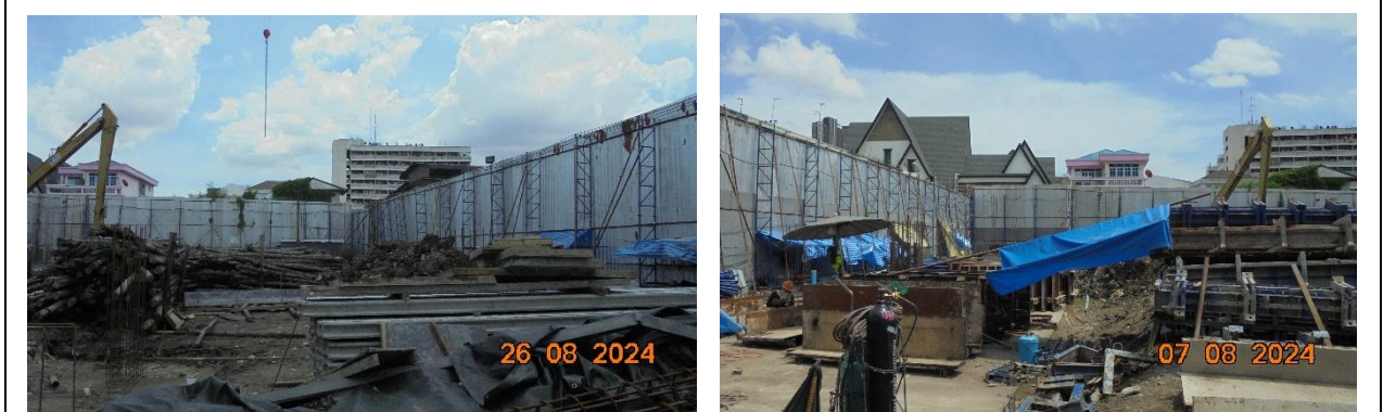
ภาพที่ ก-3 ติดตั้งรั้วชั่วคราวแบบทึบ โดยรอบพื้นที่โครงการความสูง 6 เมตร ยกเว้นด้านทิศใต้ติดตั้งสูง 7 เมตร โดยรอบบริเวณพื้นที่ก่อสร้าง
