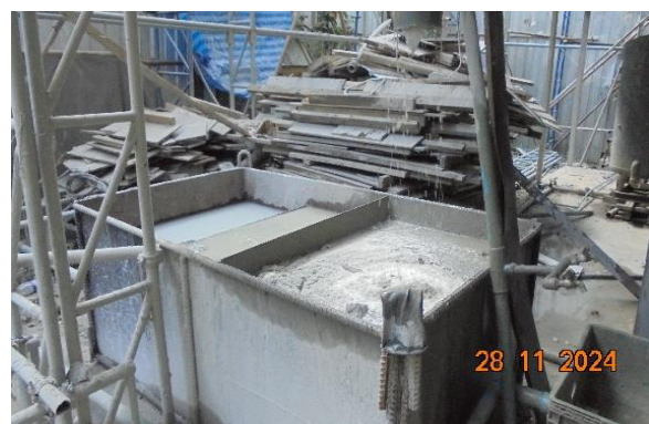
ภาพที่ ก-30 บ่อดักตะกอนดิน
